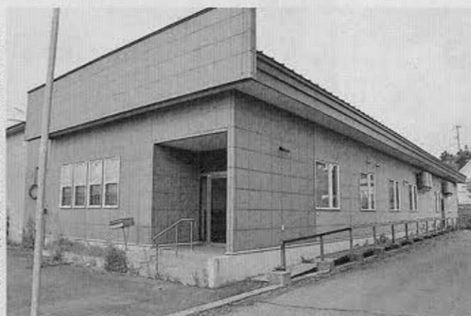
町が開設を予定している塾が設置される旧建設会社事務所
